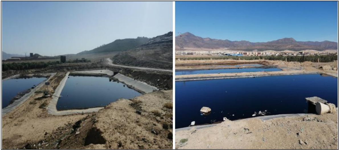
Figure 14 : Bassins de stockage des lixiviats de la ville de Batna (Photo personnelle).
